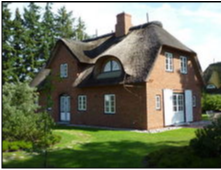
Haus Laufhütte - Ansicht von Nord-Westen
